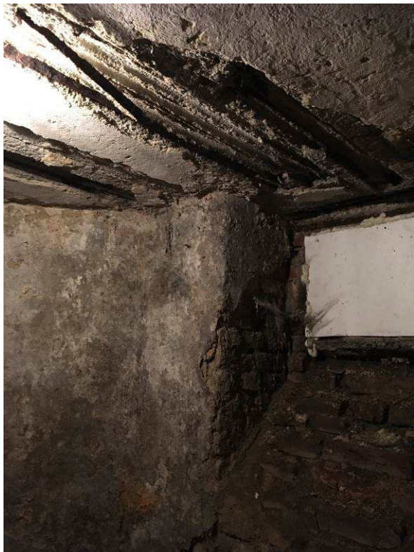
Degradované betonové desky
